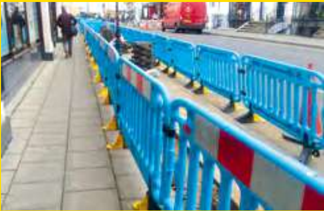
Лінія синіх огороджень Frontier®, правильно з'єднаних і з опорами для забезпечення анти-перекидання з метою додаткової безпеки пішоходів.
