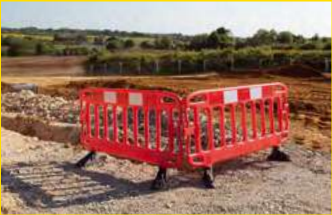
Огородження типу Navigator® розташовані навколо місця потенційної небезпеки на будівельному майданчику.
